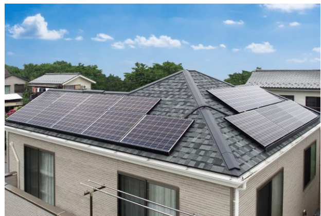
*サイズの違う太陽電池モジュール（既存製品）の設置事例
